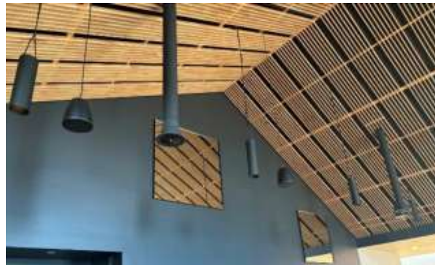
Plafond acoustique | Salle de spectacle de Petite-Vallée
